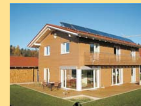
Sonnenhaus Rohleder Lärchenweg 10 83362 Surberg-Hufschlag
